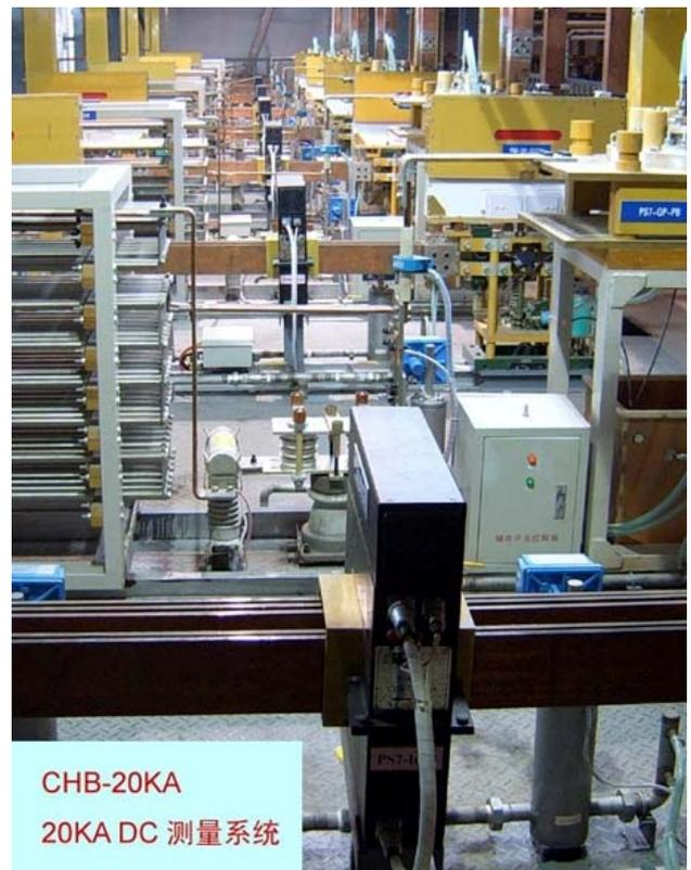
图 7 闭环霍尔电流传感器的安装现场
